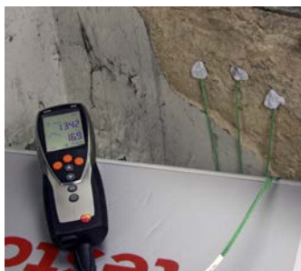
testo 435 – měření prostupu tepla stěny, kterou je potřeba sanovat pomocí sondy pro měření prostupu tepla a rádiové teplotní / vlhkostní sondy
