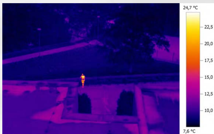
Obr. Termogram pořízen s 882 s použitím SuperResolution
