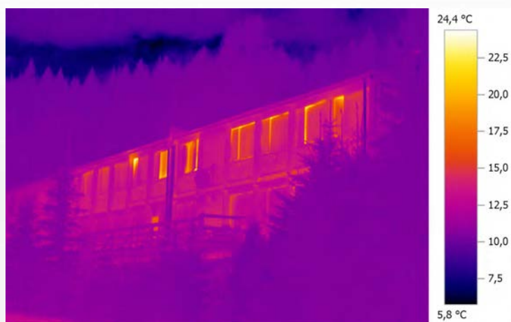
Obr. Termogram pořízen s 882 s použitím SuperResolution
