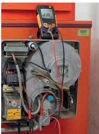
Měření ionizačního proudu s testo 760.
