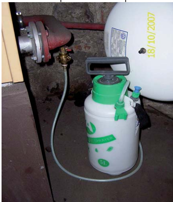
Obrázek č. 18 Plnění kapaliny do systému
