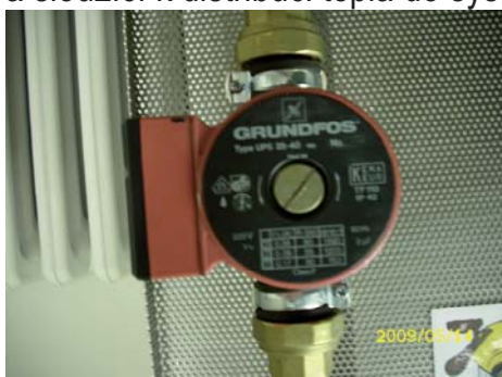
Obrázek č. 7 Oběhové čerpadlo
