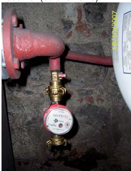
Obrázek č. 16 Stanovení obsahu systému vypuštěním přes bytový vodoměr
