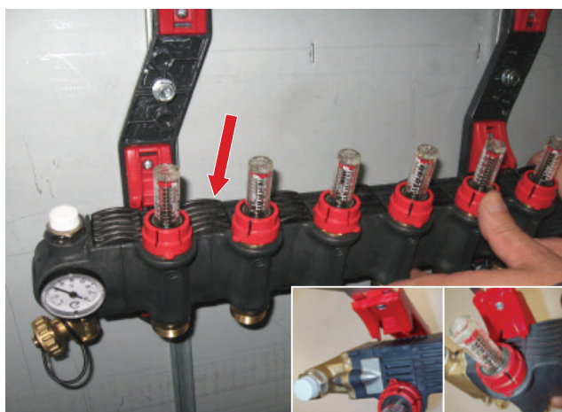
7) Zavěste rozdělovač přírodních trubek na spodní úchyty
