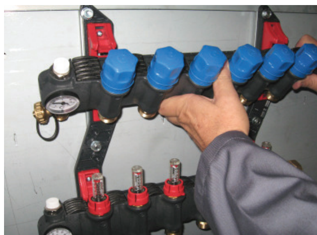
8) Rozdělovač vratného potrubí zavěste na vrchní úchyty
