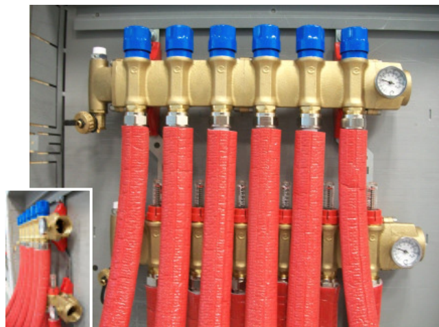
1B) Trubky zpátečky před přívodním rozdělovačem
