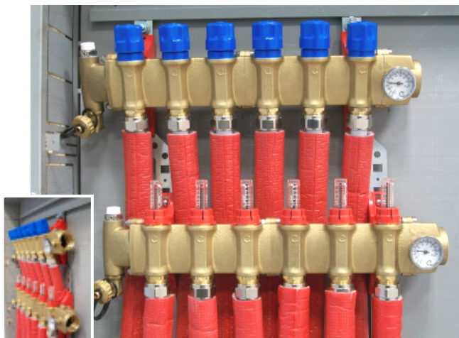
1A) Trubky zpátečky za přívodním rozdělovačem
