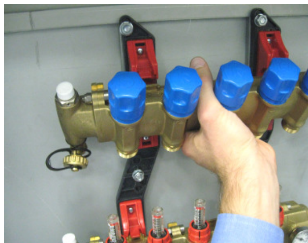
8) Nasadíte zpátečku rozdělovače do horních upevňovacích prvků
