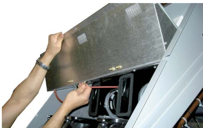
- Odstraňte silikonové trubky červené barvy a pak komoru ventilátorů.
