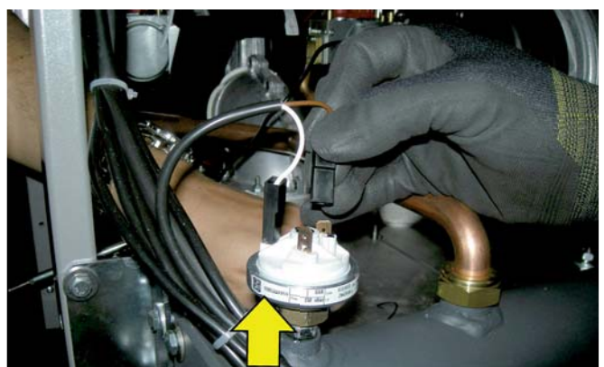
- Odstraňte připojení k plynovému presostatu.
