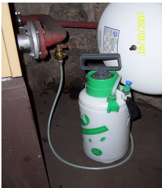
Obrázek č. 18 Plnění inhibitoru koroze do systému
