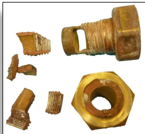
Odzinkování mosazi (selektivní koroze). Houbovitá, pórovitá měď.
