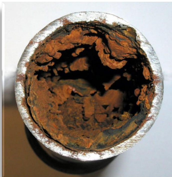
Špatně lpící koroziční produkty v ocelové trubce.
